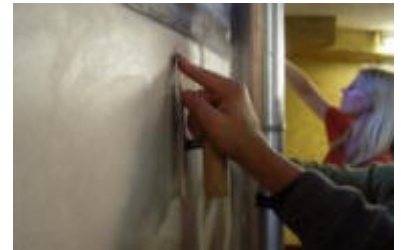
Tadelakt tiivistämistä muovilastalla
