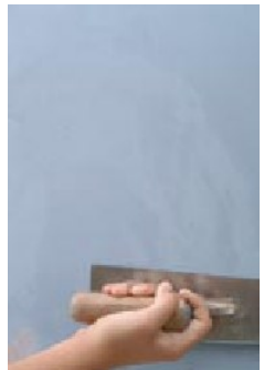
1.kerroksen levitys stuccolastalla
