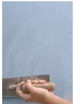
2.kerroksen levitys stuccolastalla
