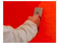
2. kerroksen levitys ja kiillotus stuc- colastalla
