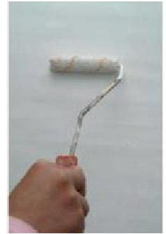
Pohjustaminen 2 kerrosta Decor Fondo primerilla
