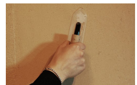
Tiivistys muovilastalla
