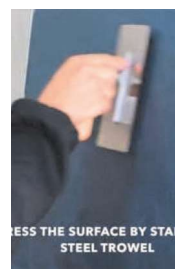
2.kerroksen tasoitus teräslastalla
