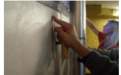
Tadelakt tiivistämistä muovilastalla
